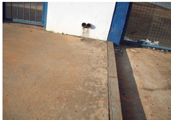
Figura 15 - Degrau na calçada.
