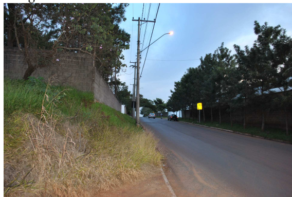
Figura 14 - Inexistência de calçada.
