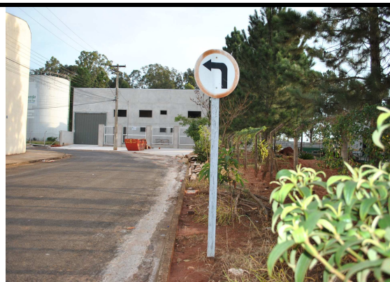
Figura 13 - Calçada irregular II.
